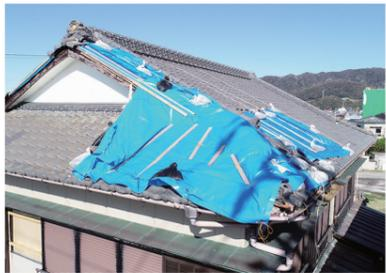
大型台風で屋根瓦が飛散しブルーシートで応急処置。雨漏り、室内のカビの原因に。
